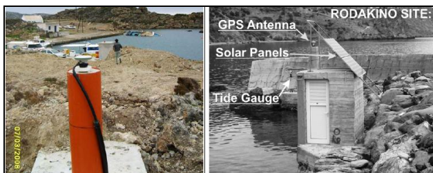
Σχήμα 4. Οι νέες εγκαταστάσεις στη Χρυσοσκαλίτισσα (αριστερή εικόνα), και Ροδάκινο (δεξιά εικόνα).
